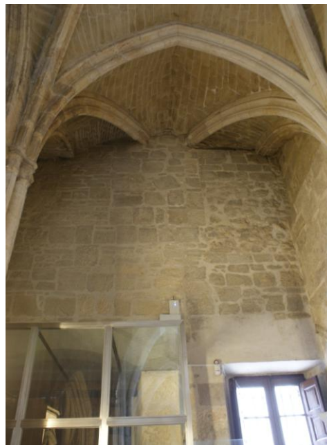
FIG. 15. CATEDRAL DE BURGOS. MURO ESTE DE LA PANDA MERIDIONAL DE LA CLAUSTRAL VIEJA, DEL SIGLO XIX, QUE MUTILÓ LAS ANTIGUAS BÓVEDAS (© CABILDO METROPOLITANO DE BURGOS)
