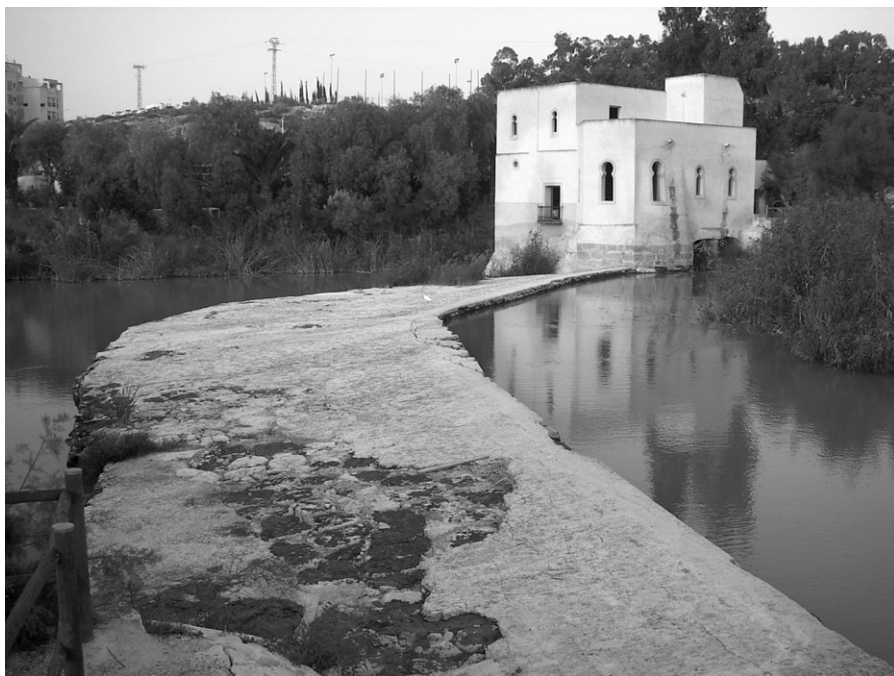
Fig. 3. Azud de San Antonio, en Guardamar del Segura, última presa de las ocho construidas en el tramo final del río para facilitar el regadío huertano en la Vega Baja, y al fondo el molino hidráulico, remozado a principios del siglo XX con estilo neoárabe, documentado ya a finales de la Edad Media.
