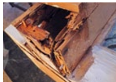
Estado de conservación de algunas piezas lignarias Foto: LUMA.
