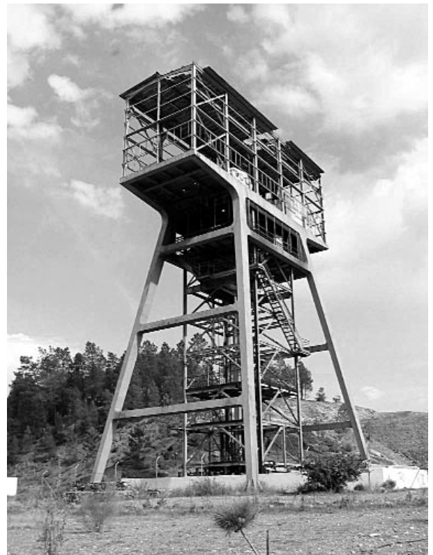
Figura 1: Malacate del Pozo Rotilio
