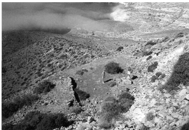
Figura 8. Punto de partida del cable aéreo en las proximidades de las canteras del cerro de Los Lobos. En el suelo se puede apreciar la bancada dónde se fijaba la infraestructura del inicio del cable. Al fondo se aprecia entre la niebla la cala del Carnaje, donde estaba el embarcadero para los adoquines
