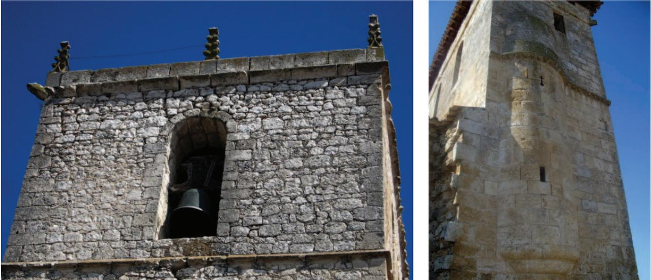
Izq. Torre de Canalejas de Peñafiel (Valdolid) con fuste liso y barandilla de coronación con pináculos góticos, desaguada por gárgolas animalísticas. Dcha. Torre de la Asunción de N<sup>a</sup> S<sup>a</sup> en Pinillos de Esgueva. Se aprecia la cornisa de bolas rodeando el garitón exterior que alberga el husillo. El encastillamiento del templo se hace patente en las almenas y la aspillera de bola y cruz visible en la imagen. Foto: J.I.S.
