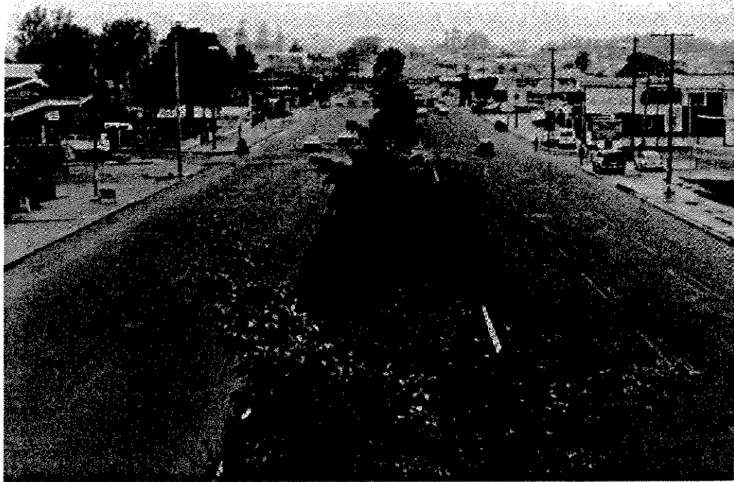
Figura 1. La carretera actual en el sitio donde atraviesa las ruinas de Kaminaljuyú. Su apertura significó la pérdida de los grupos A-III, B-4, C-IV, C-V, D-V, E-V y F-VI.
