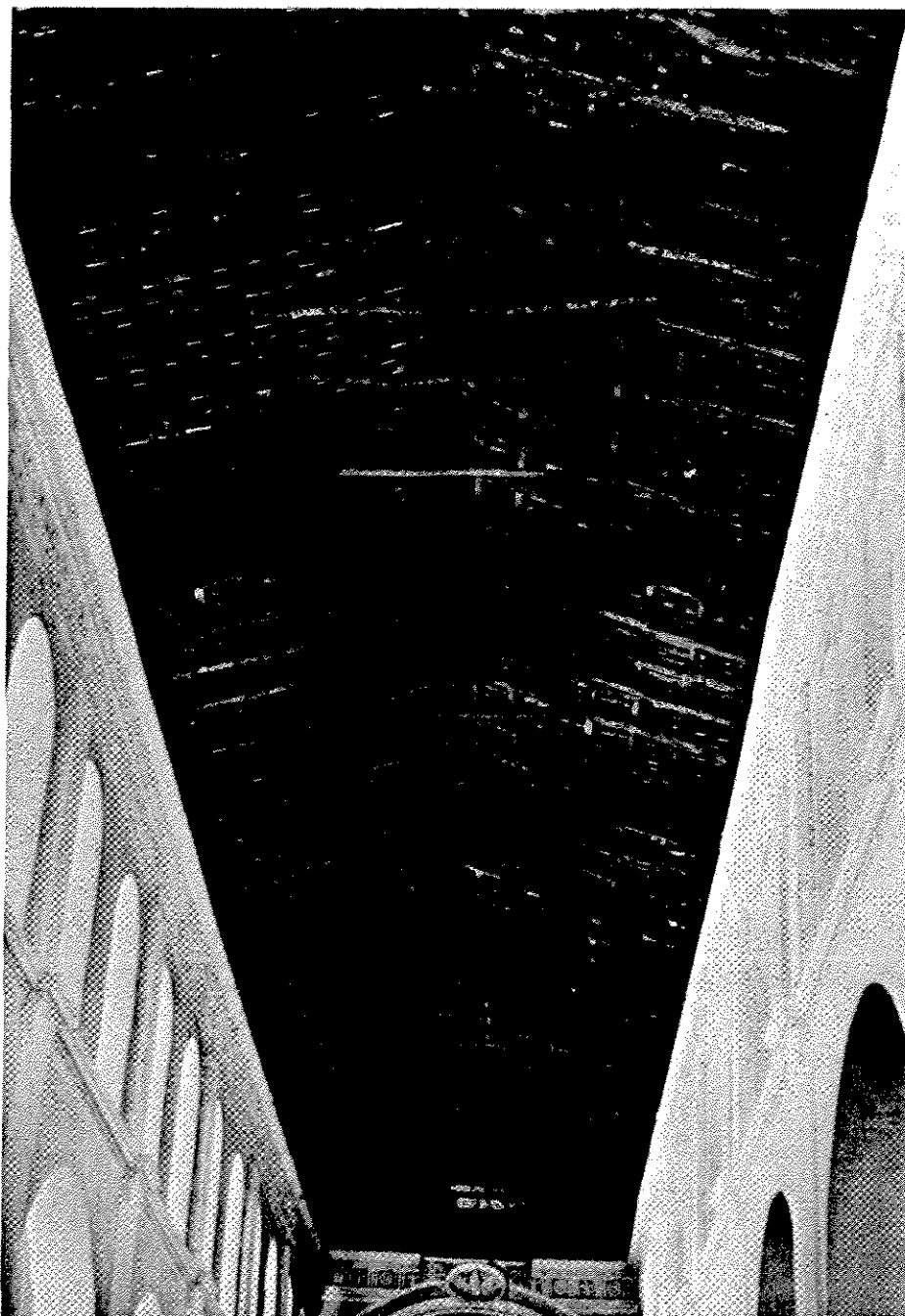
Figura 8. Chiapa de Corzo. Iglesia de Santo Domingo. Artesón de par y nudillo (¿fecha?). Nótese que falta un entablado y las tejas del techumbre que descansan en listones atravesando los pares están expuestas a la vista.
