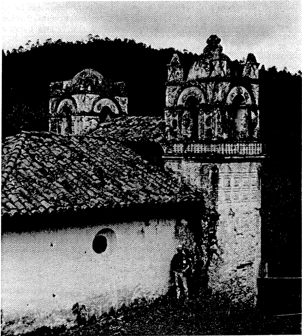
Figura 6. Aquespala. Iglesia en ruinas. La fachada es de mampostería. Los muros laterales eran de adobe, y su construcción era independiente de la fachada.
