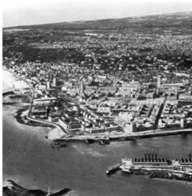
Panorámica del Habra antes de finalizar su reconstrucción
