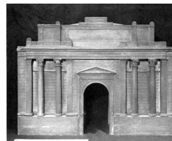
Bank: frente sur, ala este
