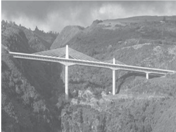
Figura 3. Viaducto de Trois Bassins en La isla Reunión.
