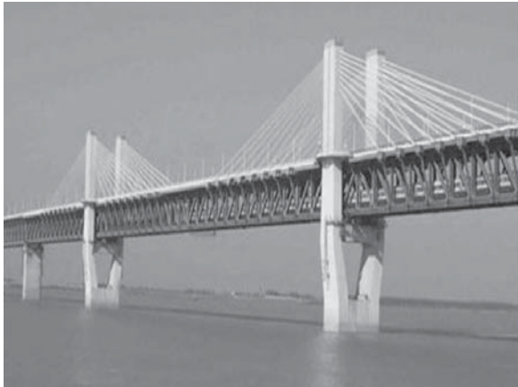
Figura 8. Puente Wuhu sobre el Río Yang-Tze en China.
