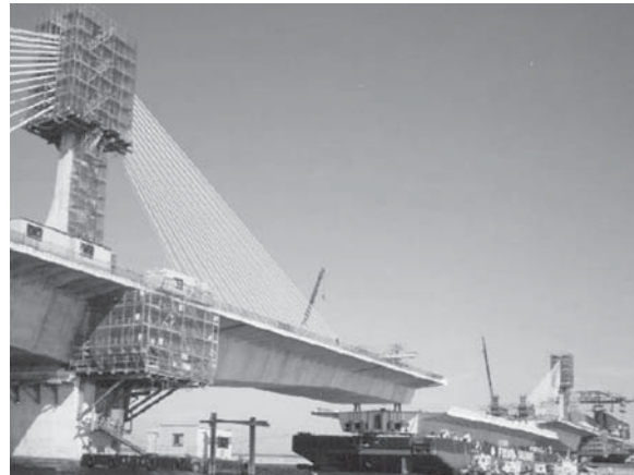
Figura 9. Erección de la viga metálica en el Puente Ibi Gawa en Japón.
