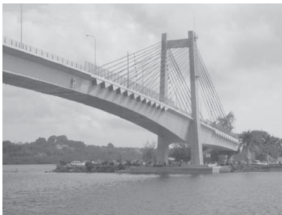
Figura 5. Puente Koror-Babeldaob en La República de Palaos.
