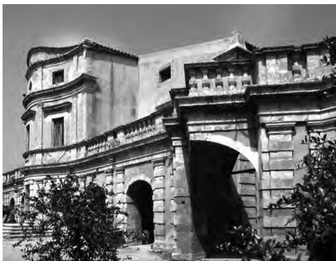
Fig. 11 Noto (Siracusa). Villa Nicolaci, veduta del fronte principale.
