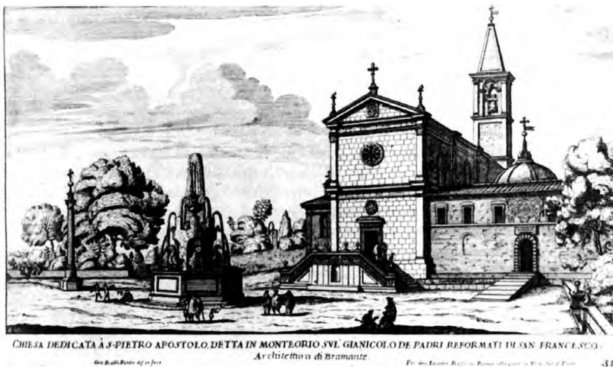
Fig. 7. Complesso di San Pietro in Montorio, incisione (da G. B. Falda, Nuovo teatro delle fabbriche et edifici, in prospettiva di Roma moderna, Roma 1665-69).
