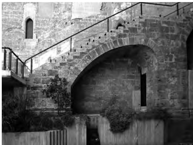
Fig. 4. Palermo. Palazzo Chiaromonte (Steri), parte superstite della escalera descubierta, dopo gli interventi di liberazione e di completamento attuati in occasione del restauro del palazzo.
