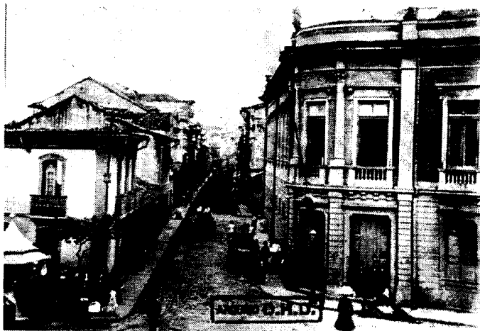
Fig. 9 – Colégio Pedro II – reconstrução de Bethencourt da Silva (Arquivo da Cidade do Rio de Janeiro).
