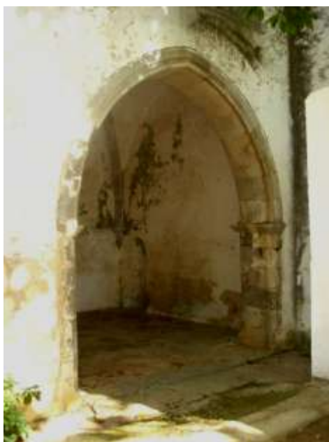
Fig. 4. Aspecto geral da Capela “dos Machados”. Foto do autor
