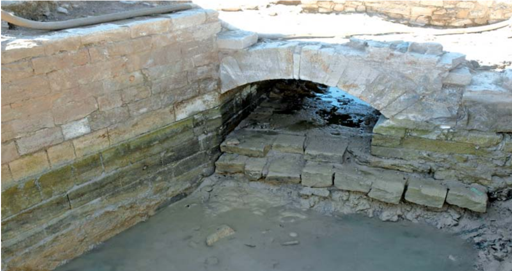
Fig. 4b. Detall de la fonamentació del tram sud excavat del pont i filades inferiors del cap de pont, des de l'est.
