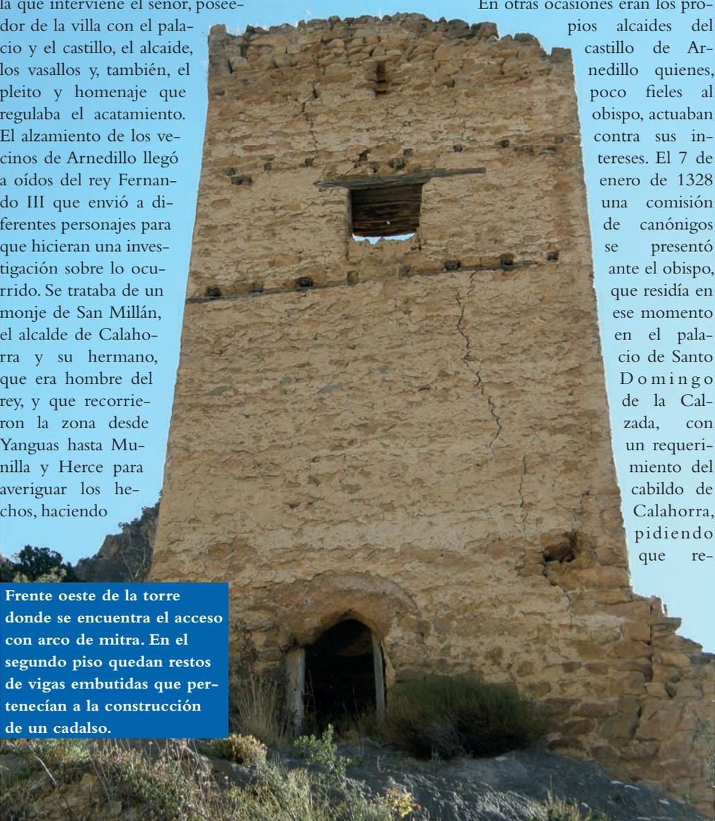
Frente oeste de la torre donde se encuentra el acceso con arco de mitra. En el segundo piso quedan restos de vigas embutidas que pertenecían a la construcción de un cadalso.
