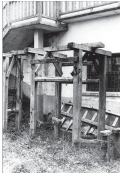
Estructura de un potro de cuatro columnas del caserío Urtarte, del barrio irunés de Behobia.
