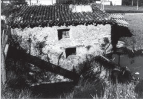
Edificio junto al río Errezil donde se encuentra la “destera” o piedra de afilar de la familia Churruca, en la villa de Regil.
