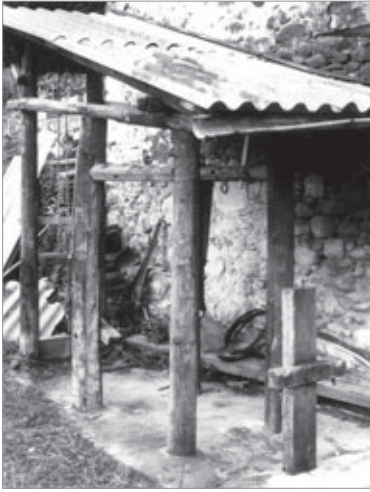
Detalle de los soportes reposa-patas del potro del caserío Alunda de Irún. En primer plano el soporte delantero y al fondo el trasero.
