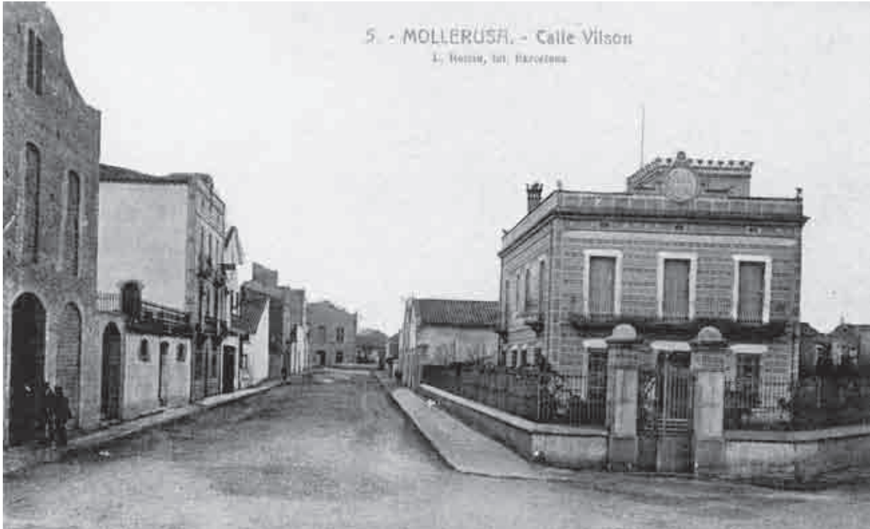
Antic carrer Wilson, actual avinguda de la Generalitat. Un dels primers eixamples construïts entre finals del segle XIX i principis del XX.
