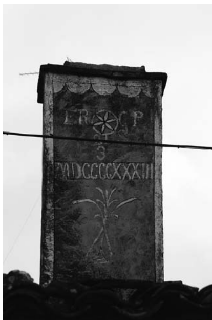
Fig. 5. Chimenea con iniciales, fechas y símbolos protectores esgrafiados de La Atalaya (Salamanca).
