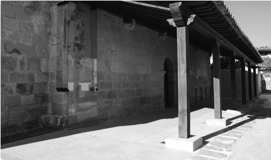
Fig. 18. Pórtico y pinturas de la iglesia del Santo Sepulcro tras su restauración e instalación de protecciones
