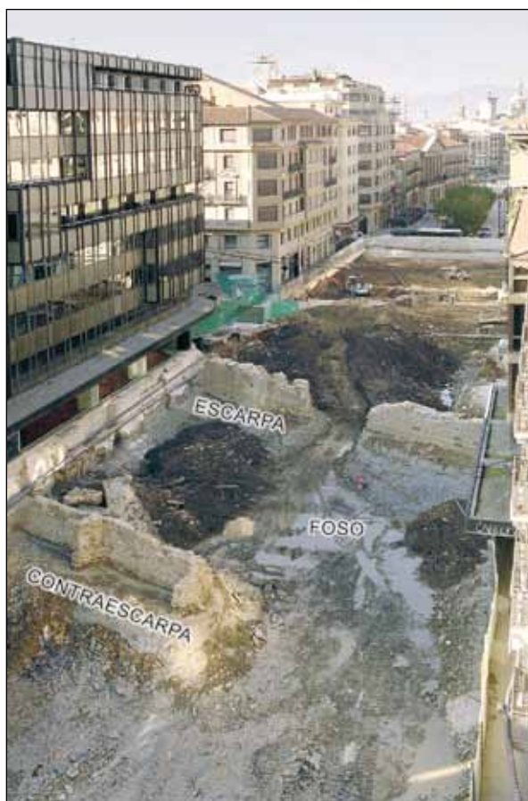
Vista contraescarpa, foso y escarpa.
