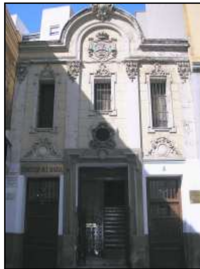
IMAGEN 4. FACHADA ACTUAL DE LA CAPILLA DEL AVE MARÍA 5
