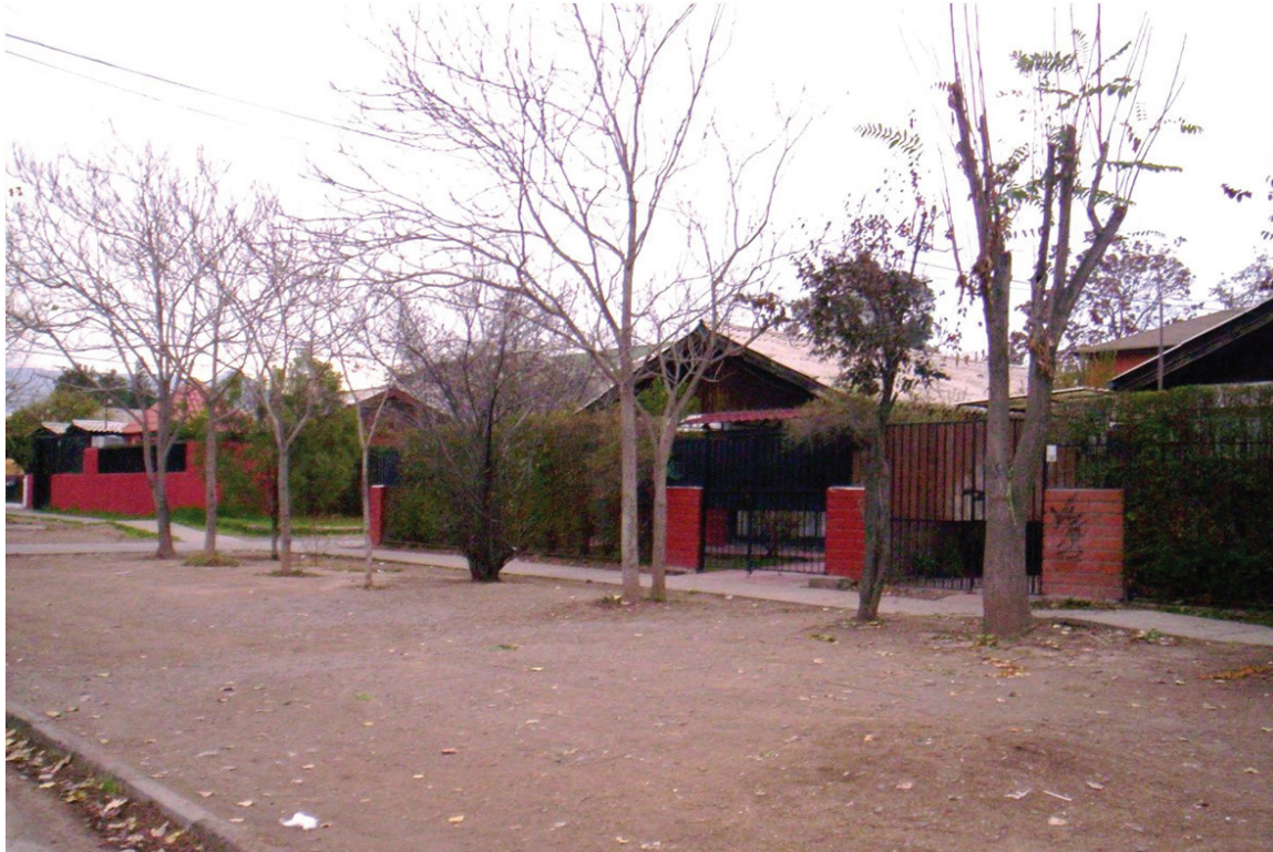
Figura 0. Espacio urbano en el Barrio de Valladolid caracterizado por su baja densidad (Comuna de La Florida, Santiago de Chile)
