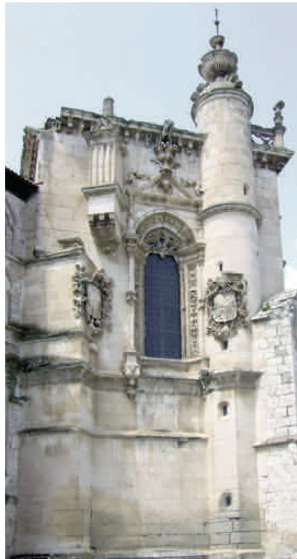
Fig. 17. Flameros en la cubierta de la capilla.
