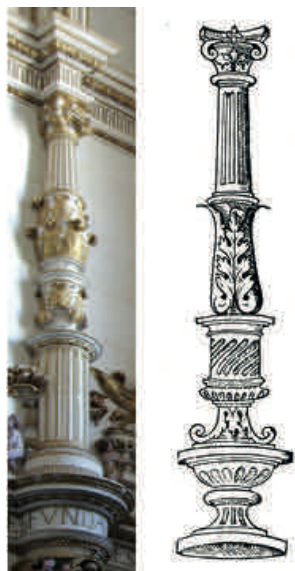
Fig. 10. Columna de la capilla de don Juan Manuel. Modelo de columna abalaustrada propuesta por Diego de Sagredo.
