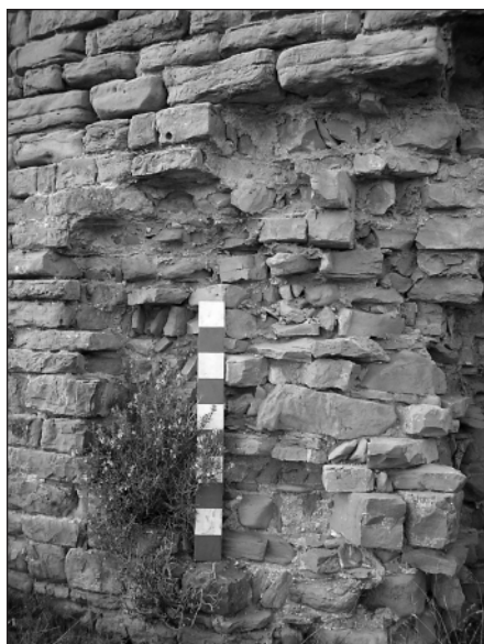
Fig. 4 : Arcusa angle nord de la tour
