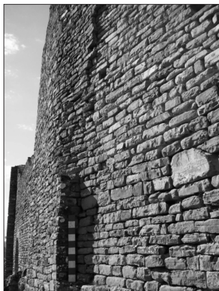
Fig. 5 : Boltaña vue du mur est (côté extérieur)
