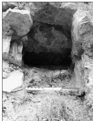
Clamosa : dans le mur nord-ouest
