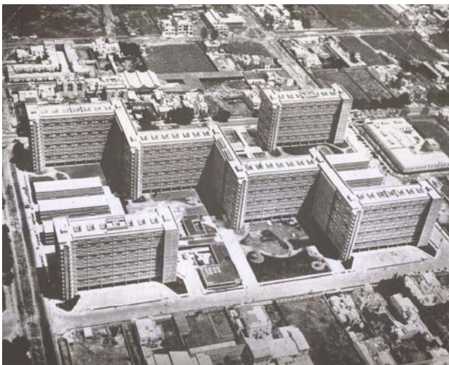
Figura 4: Centro Urbano Presidente Alemán (CUPA), primer conjunto de vivienda multifamiliar desarrollado en la Ciudad de México por Mario Pani y asociados (Taller de Urbanismo) en 1947-1949, incorporando el modelo urbanísticos de la Ville Radieuse propuesto por Le Corbusier donde se proyectó un continuo de bloques de edificios dejando libre la planta baja. Reproducido de: González Gortázar ed. (1994).
