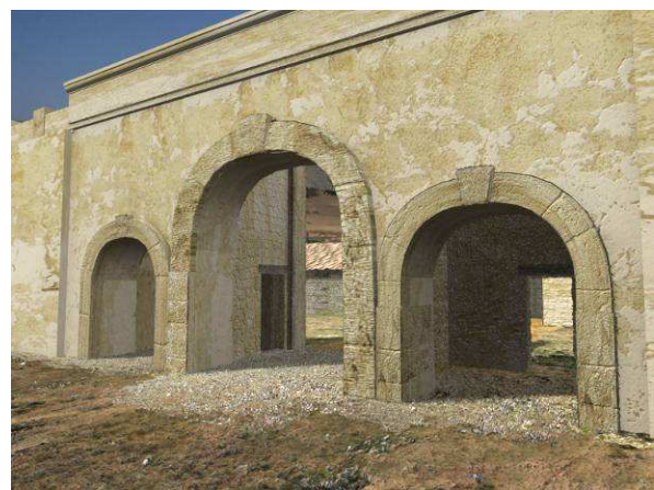
Figura 5. Tercera fase de la puerta este en la que se aprecia el recrecimiento del nivel de suelo y el cambio de vanos en los cubos interiores
