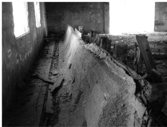
Figura 5. Planta del edificio de tratamiento mineral de la mina San Carlos tras la reconstrucción de la maquinaria y de las piletas de procesado. Debajo, dos fotografías del estado abandonado del edificio.
