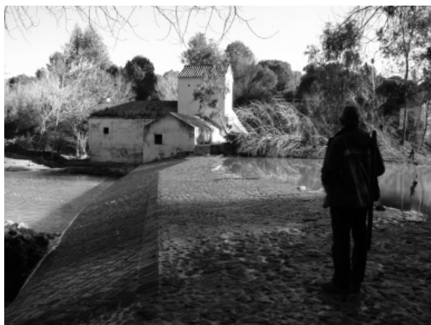
Figura 1. Azud en Alcalá de Guadaira
