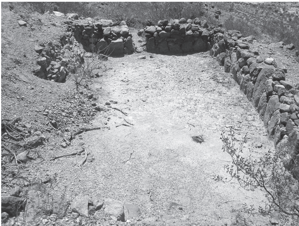
Figura 9. Recinto 5, construido con pirca doble y en terraplén, con bloques de granito. Siendo que las paredes se encuentran prácticamente descubiertas podría tratarse de uno de los recintos excavados por González.
