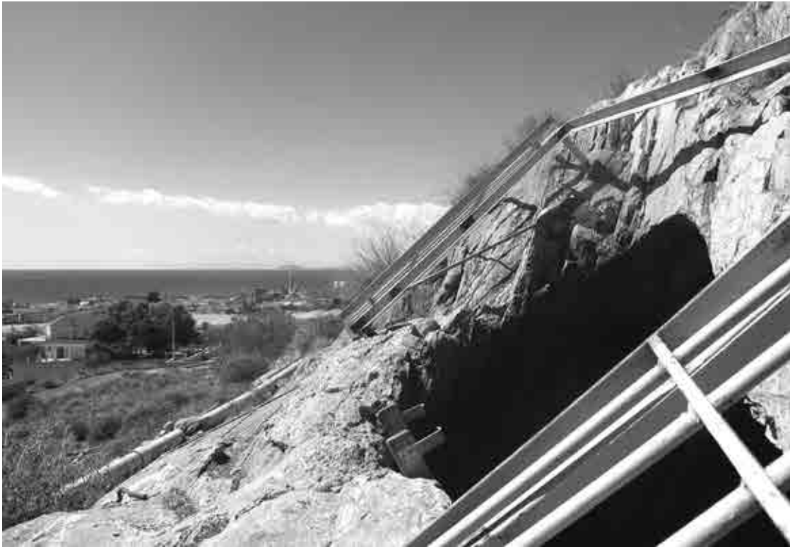
Fig. 4a. Acceso a la sala central. a la izquierda, las urbanizaciones de Isla Plana con el mar tras ellas.
