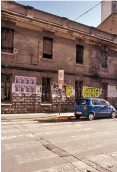
Figura 4. Foto conjunto Teodoro Camino c/v Tinte, 1924. Demolido.
