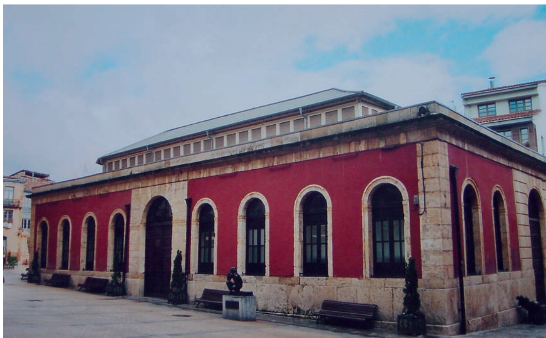
Fig. 3. Cándido González, Mercado de Trascorrales, Oviedo. 1862-1865. Foto del autor.
