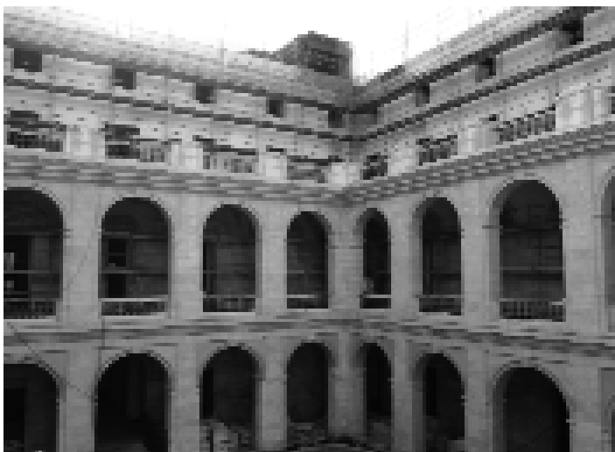
Interior en obras del Palacio de la Aduana
