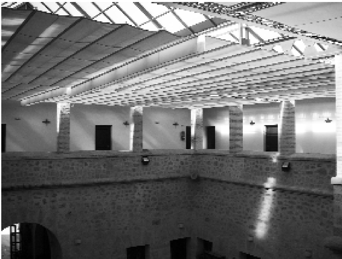
Castillo del Marqués. Piso superior con los pabellones añadidos en 1919 y la cubierta acristalada actual.
