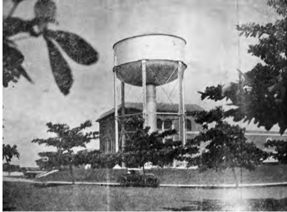
Imagen 1. Planta de filtración del acueducto de Barranquilla
