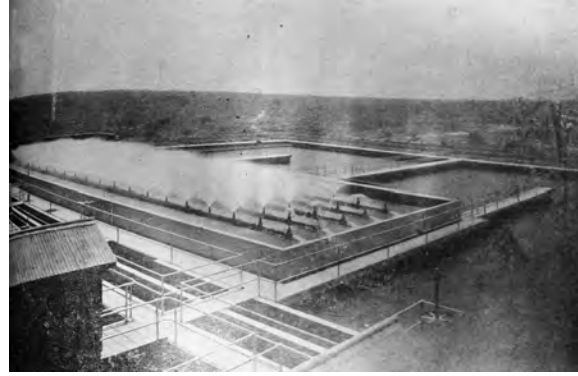
Imagen 2. Tanques de decantación del acueducto de Barranquilla. AHA, Colección Hemerográfica, Revista Mejoras , Barranquilla, junio de 1937.
