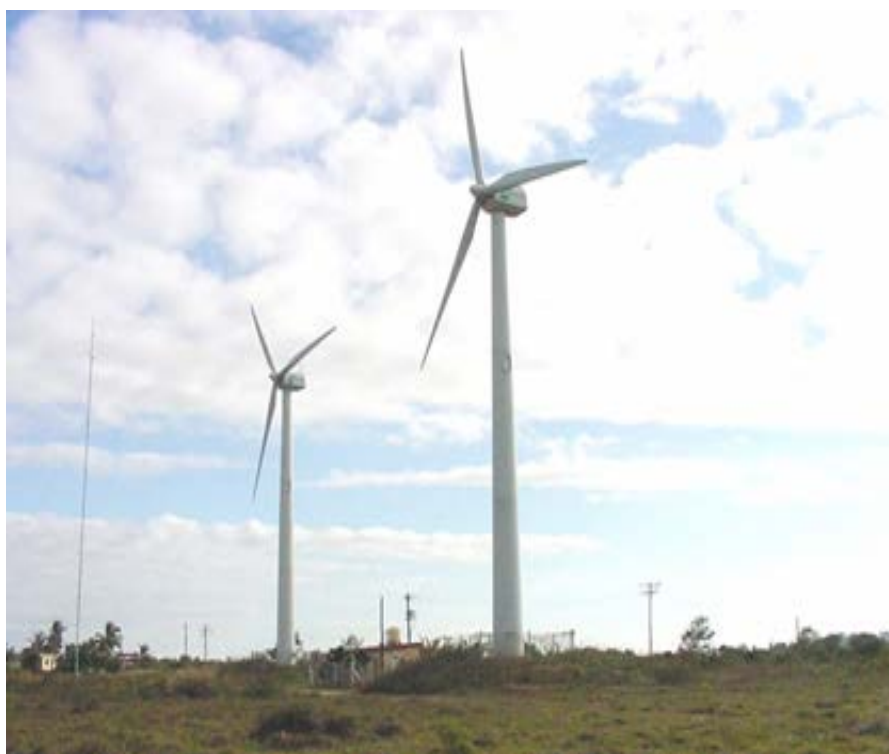
Figura 1. a) Parque Eólico de Turiguanó,
