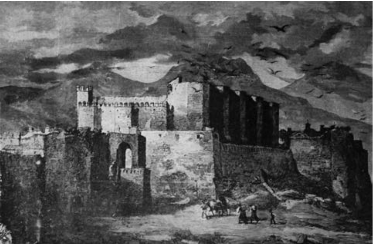
Figura 4. Grabado del año 1873, donde se observa el tambor con las aspilleras.
