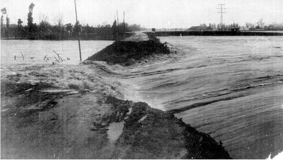
**Figura 1.** Ruptura del Muro de Defensa del Tamarguillo.
