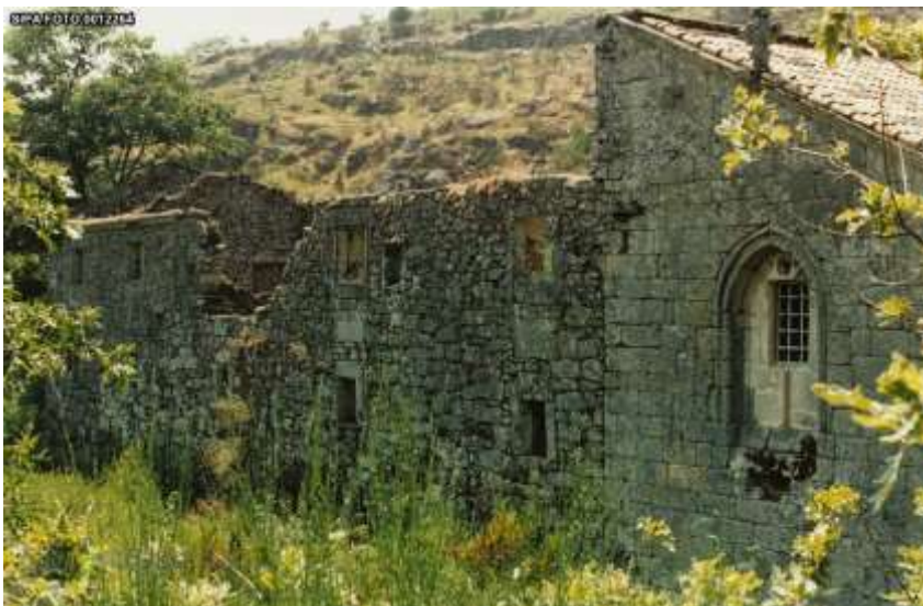
Fig. 13 – Fachada oriental da igreja [ www.monumentos.pt ].
