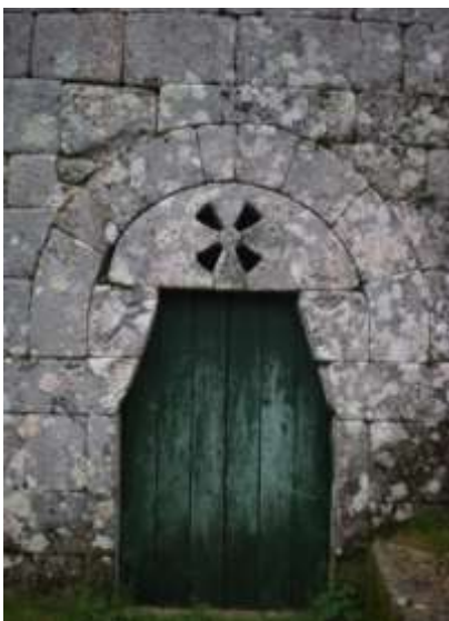
Fig. 6 – Portal lateral Sul.
