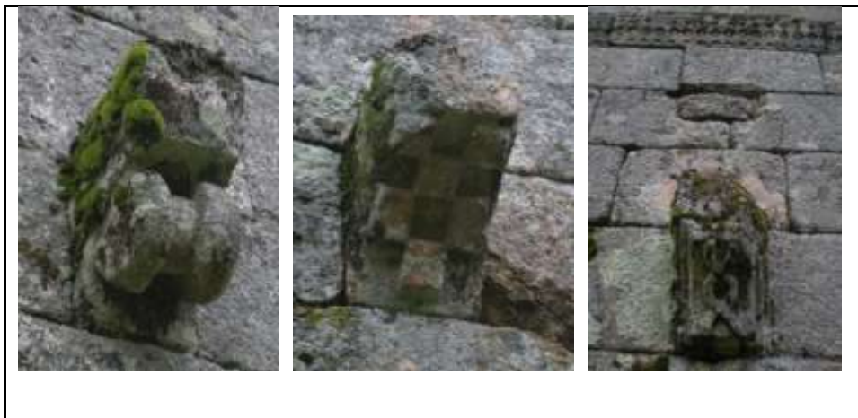
Fig. 12 – Exemplos de cachorros da fachada lateral Sul.
