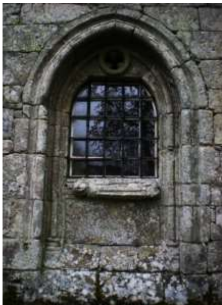
Fig. 4 – Janela setentrional da cabeceira, com escultura de monge jacente.
