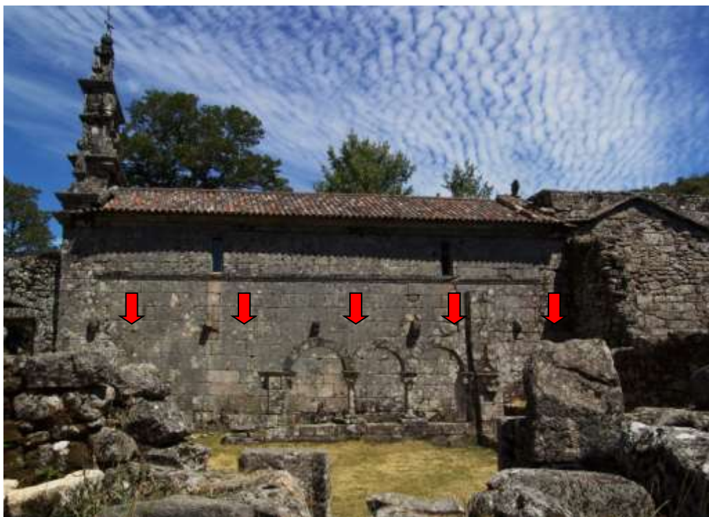
Fig. 11 – Fachada lateral Sul com indicação dos cachorros (fotografia gentilmente cedida pelo Ecomuseu do Barroso) [adaptado].
