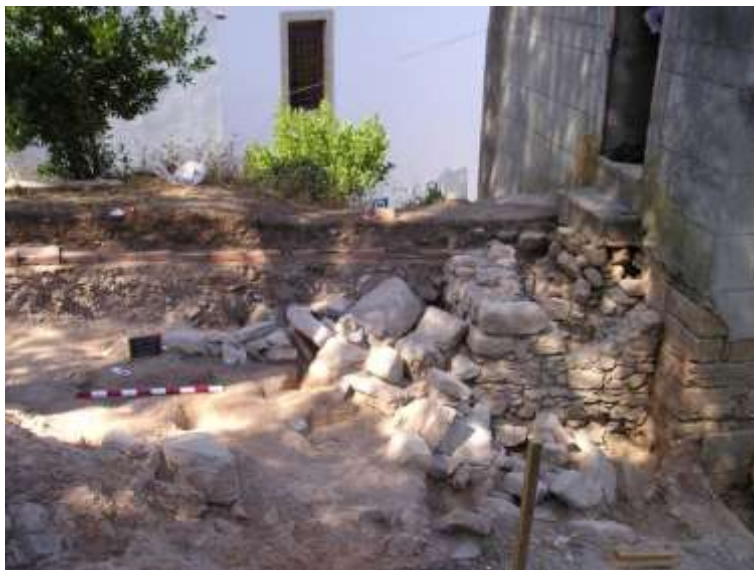
Figura 6 – Aspeto dos trabalhos: derrube da muralha e estrutura moderna de acesso à Torre. Ao fundo, vê-se a fachada SO da Igreja Matriz.
