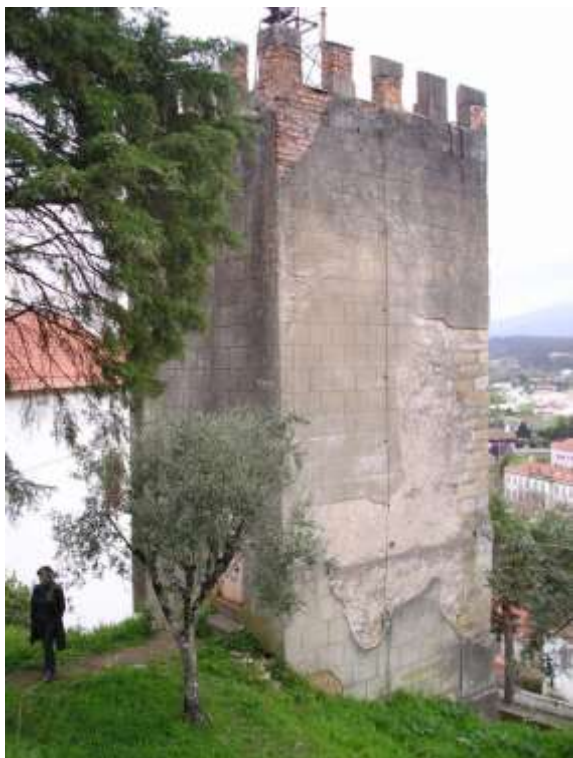
Figura 3 - Torre Sineira de Miranda do Corvo: aspecto anterior à intervenção arqueológica (Março 2011). Localização da sondagem inicial.
