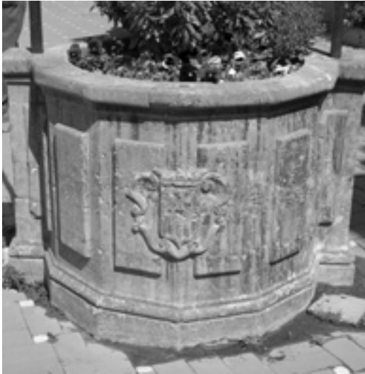
Fig. 20: Brocal de pozo del convento de la Merced, dotado del escudo de la orden, en la casa de la familia Martos (plaza María Auxiliadora)
