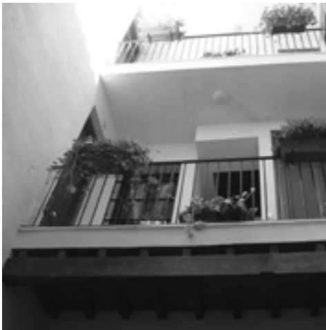
Detalle de los balcones de las viviendas, c/ Álvarez
