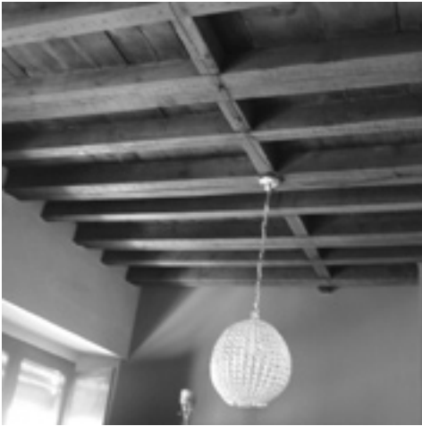
Detalle del techo con vigas de pino de Flandes, c/ Álvarez, 1
