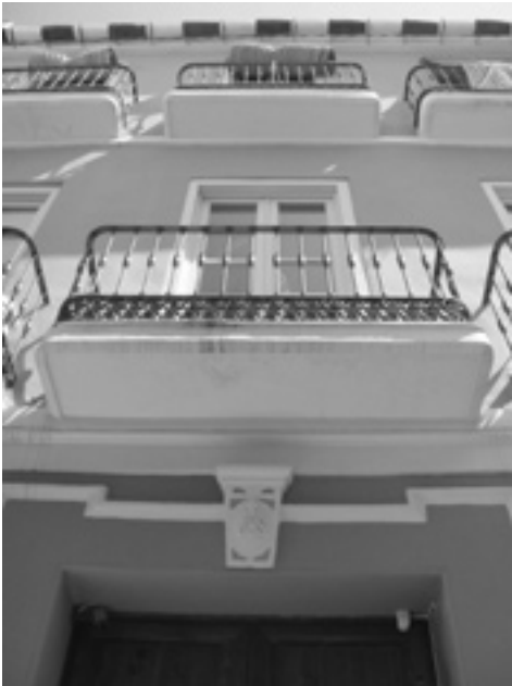
Fachada principal. Molinillo del Aceite, 4
