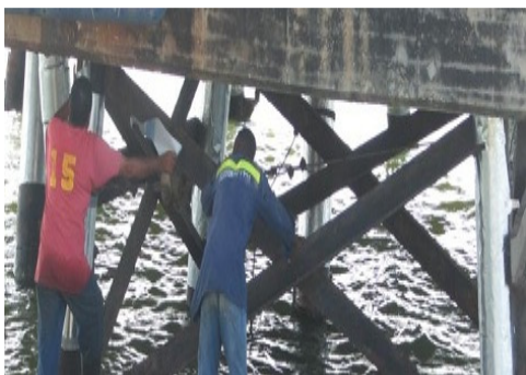
Figura 7. Aplicación de Zinc Tape®
