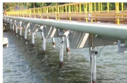
Figura 4. Estado final de los pilotes luego de la intervención
