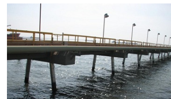
Figura 2. Protección a los pilotes de Acero
