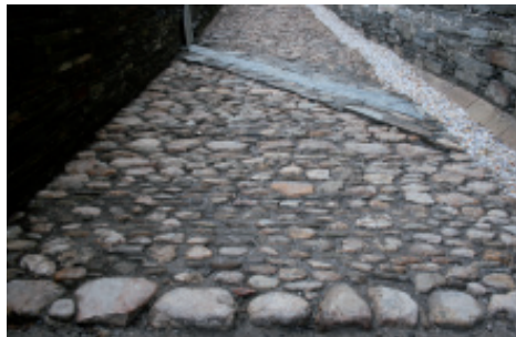
Fig. 5: Aspecto final dos traballos de recuperación das estruturas no sector exterior.
