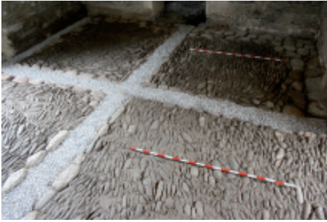
Fig. 19. Entrada ao Claustro Novo pola Porta dos Carros. Estado final do piso recuperado.
