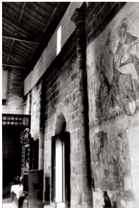
Fig. 4.- Muro de la nave norte de san Vicente de Pombeiro. (Archivo Yzquierdo).
