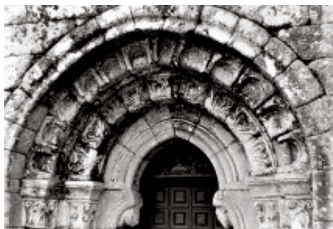
Figs. 9 y 10.- Muro sur de San Vicente de Pombeiro y detalle de su puerta. (Archivo Yzquierdo).
