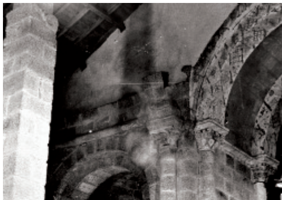
Fig. 2.-San Vicente de Pombeiro.- Detalle de la capilla mayor y arranque de bóveda sobre el arco de la capilla norte. (Archivo Yzquierdo).
