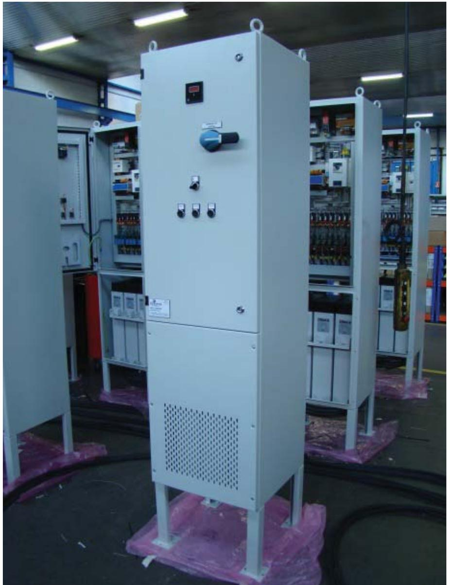
Este sistema dinámico con tiristores realiza una compensación en el punto de medida de alta tensión de la subestación eléctrica del parque mediante las consignas de un controlador ubicado en la propia subestación. El sistema es de fácil integración en la turbina pues posee unas dimensiones ajustadas específicamente para cada proyecto y un peso ajustado para un fácil y rápido montaje dentro del aerogenerador.
