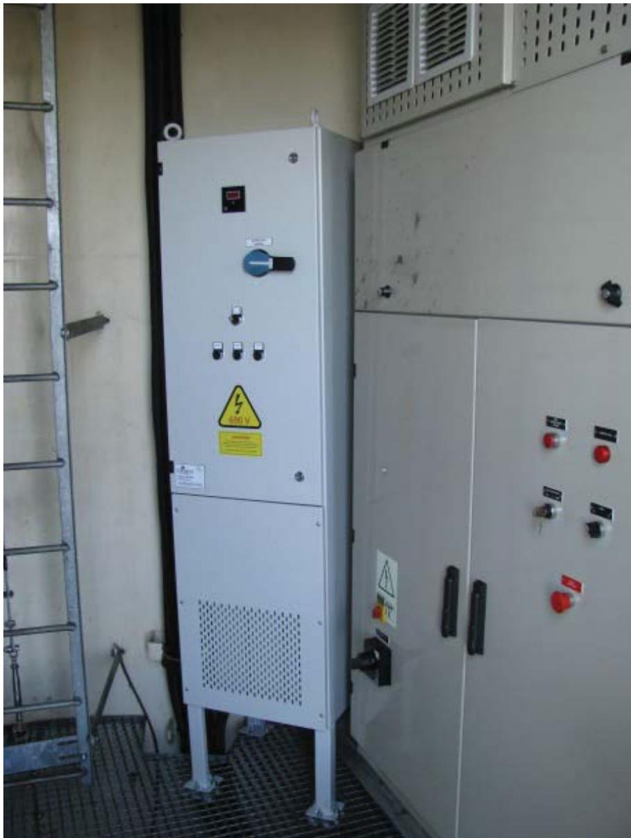
Sistema de compensación de reactiva diseñado y fabricado por Elinsa:
