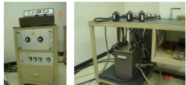
Figura 2. Calibración de transformador.
